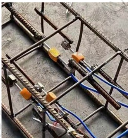
图 4 接长杆安装法
