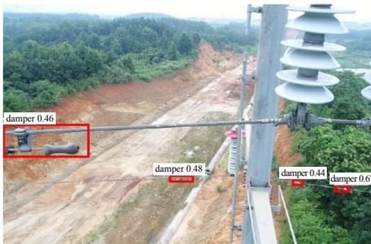
图7 防震锤的检测结果
